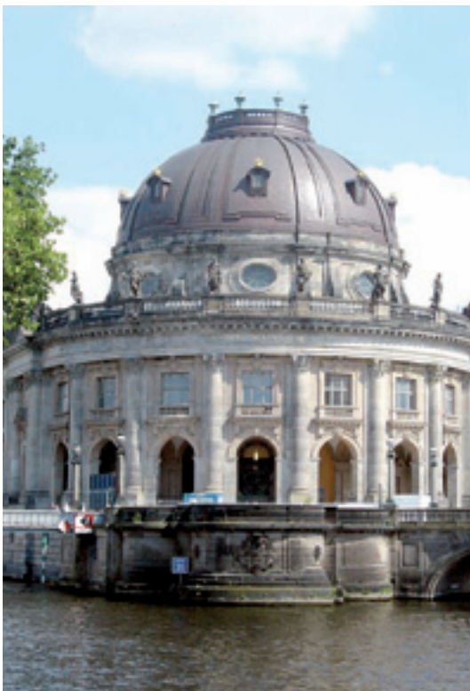
Bode Museum Berlin, Leistungen pbr AG: Technische Ausrüstung
