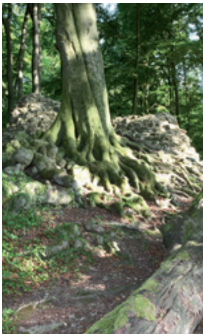
Abb. 2: Holter Burg. Die Wurzeln der Buche gefährden die baulichen Reste der Anlage.
