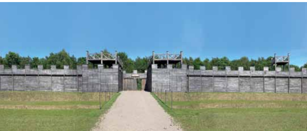
Abb. 3: Rekonstruktion von Westtor und Holz-Erde-Mauer des Hauptlagers von Haltern. Foto: LWL-Archäologie für Westfalen / S. Brentführer
