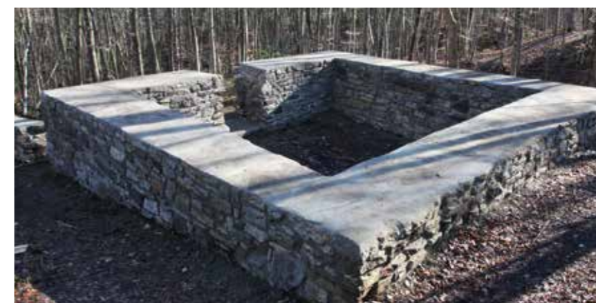
Abb. 5: Viereckturm nach der Sanierung im Frühjahr 2020. (Foto: Stadt- und Kreisarchäologie Osnabrück)
