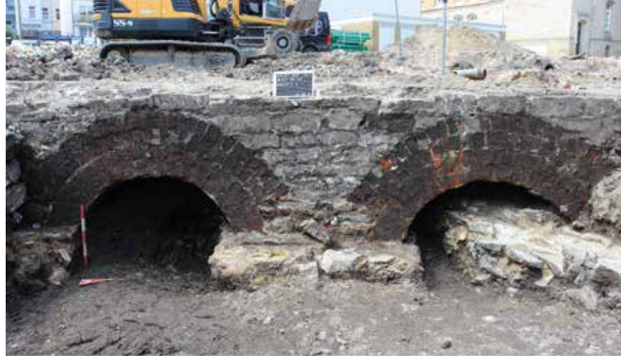
Abb. 4: Unterbau aus Pfeilern (hier nur der obere Bereich) und Bögen unter dem in den 1870er Jahren errichteten Gefangenenhaus. Im Hintergrund steht das Landgericht. (Foto: Stadt- und Kreisarchäologie Osnabrück)
